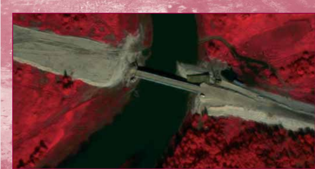
Рис. 12. Строящийся мост (снимок WorldView-2, синтез в псевдоцветах)
