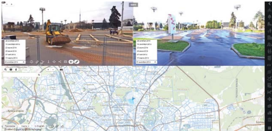
Рис. 2. Контроль хода капитального ремонта здания с помощью трехмерных панорам ЕГИП
