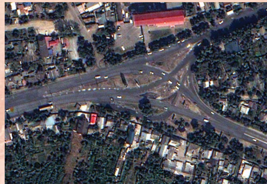
Состояние автодорожных развязок
