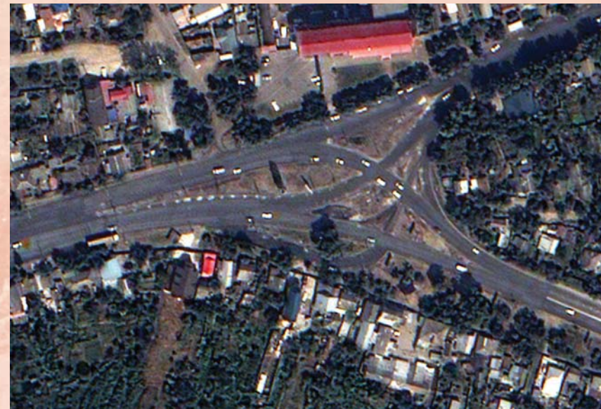
Состояние автодорожных развязок
