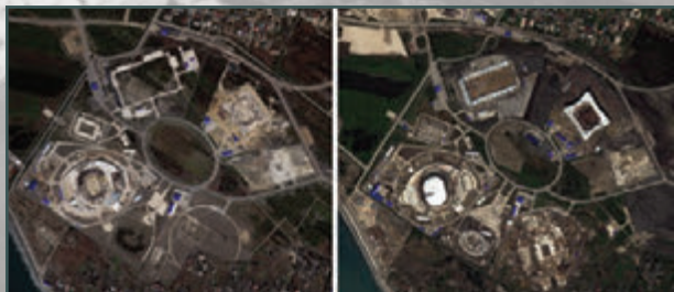
Строительство олимпийских объектов Сочи. (Космические снимки со спутника Worldview-2: слева – 28 марта 2010 г., справа – 30 мая 2011 г.).
