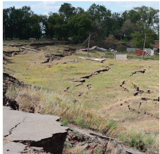
Рис. 3. Прилегающие территории покрыты трещинами
