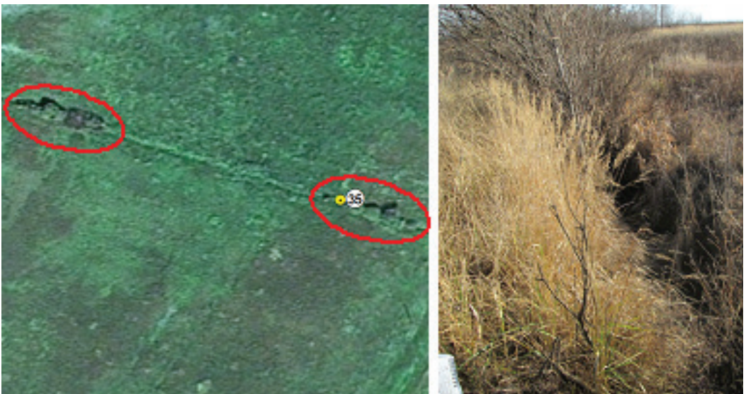
Рис. 7. Оросительный канал, заросший кустарниковой растительностью. МС Красная Заря (слева — космический снимок GeoEye-1, справа — фото 2014 г., фото с точки 35)
